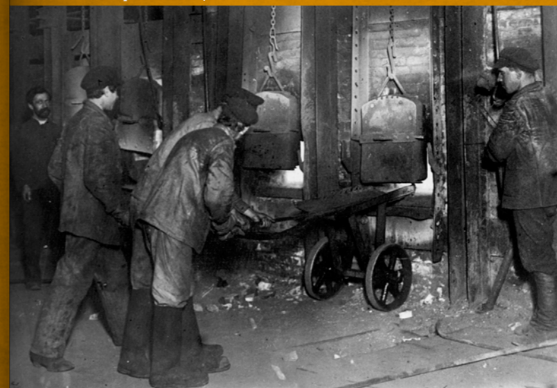
Прокатный цех №1. Нагревательная печь стана 600
