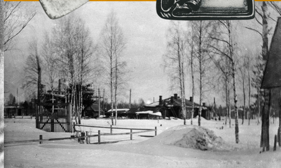
Первая железнодорожная станція Затишье, построенная в 1917 году
