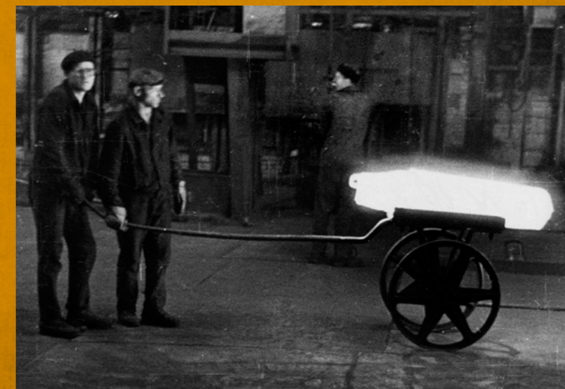
Прокатный цех №1. Нагревательная печь прокатного стана 600
