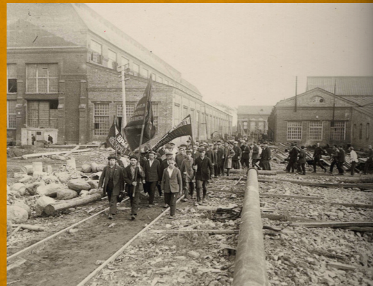
Выход на демонстрацию. Слева — здание СПЦ-1
