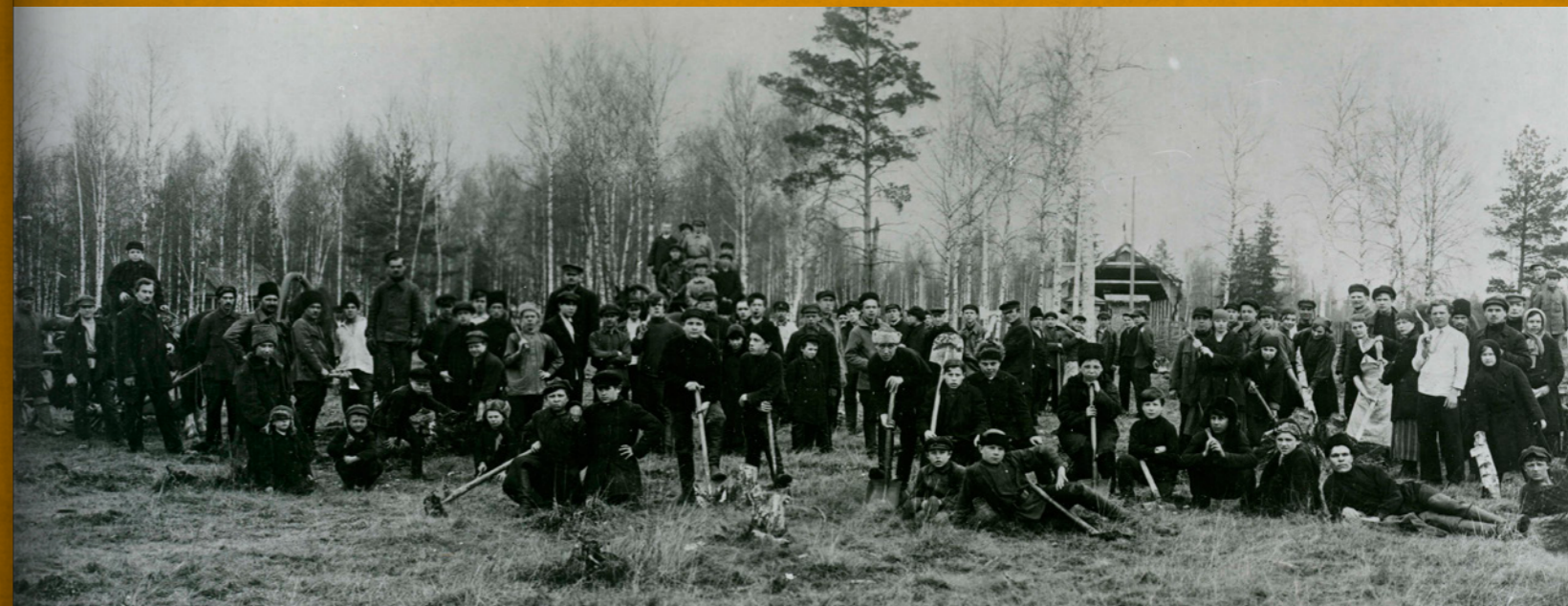
Комсомольский субботник на строительстве стадиона. 1920-е годы
