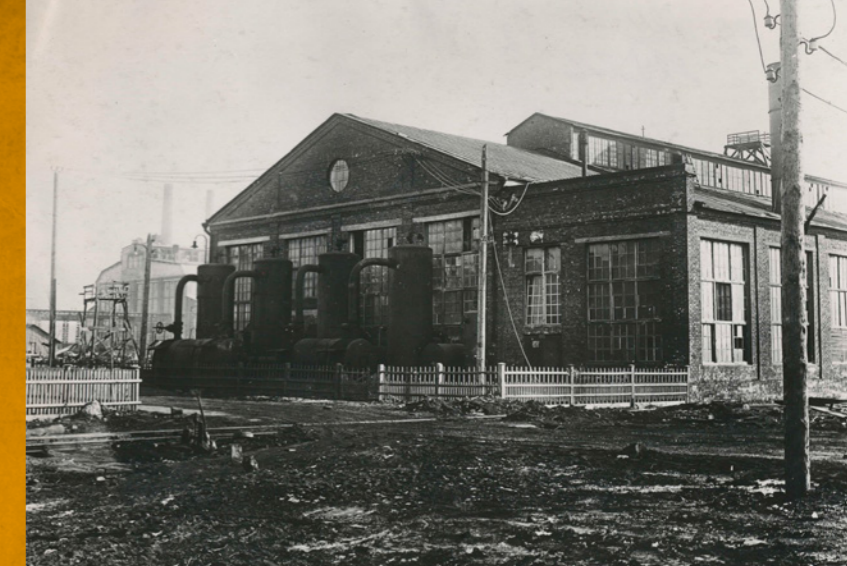
Компрессорная завода «Электросталь»
