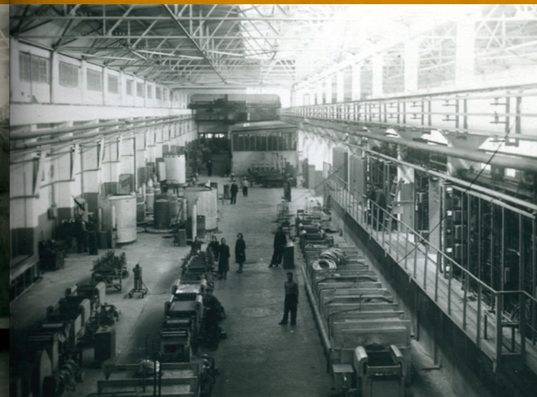
Прокатный цех №2. Участок термических печей
