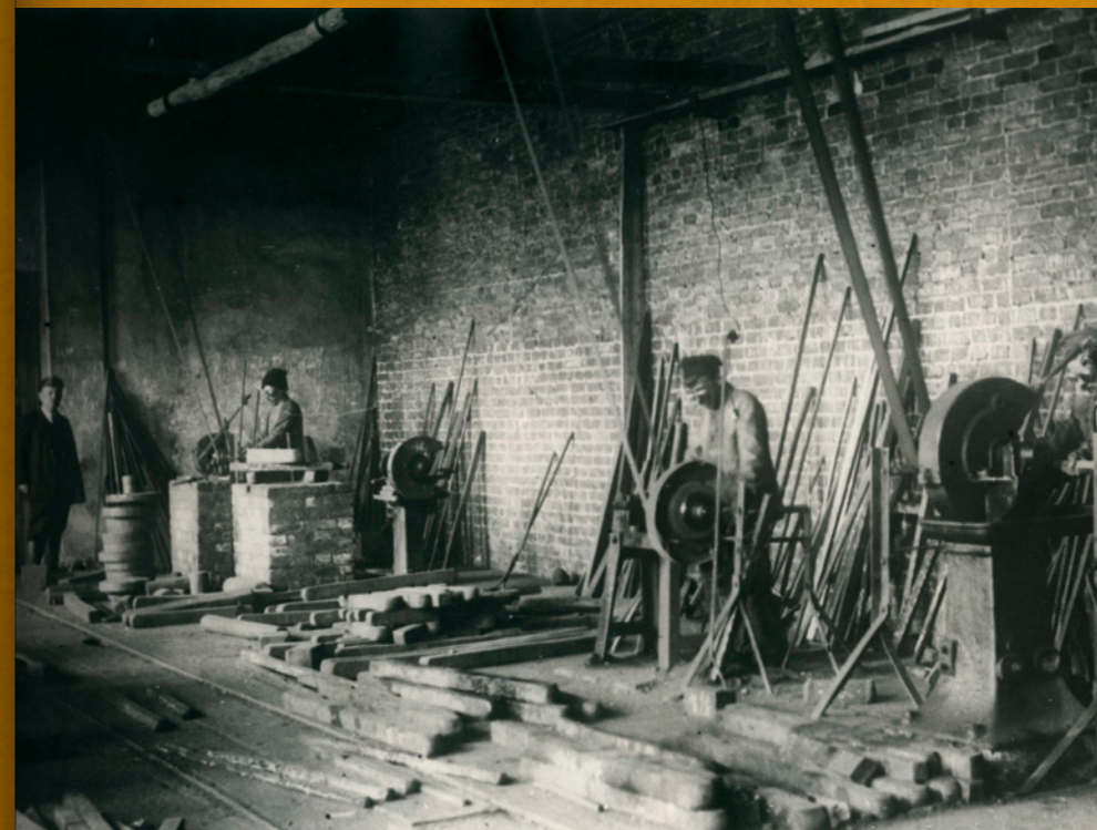
В точильной мастерской завода. Вычистка дефектов металла на стационарных наждачных станках в кузнечно проктном цехе. 1923 год
