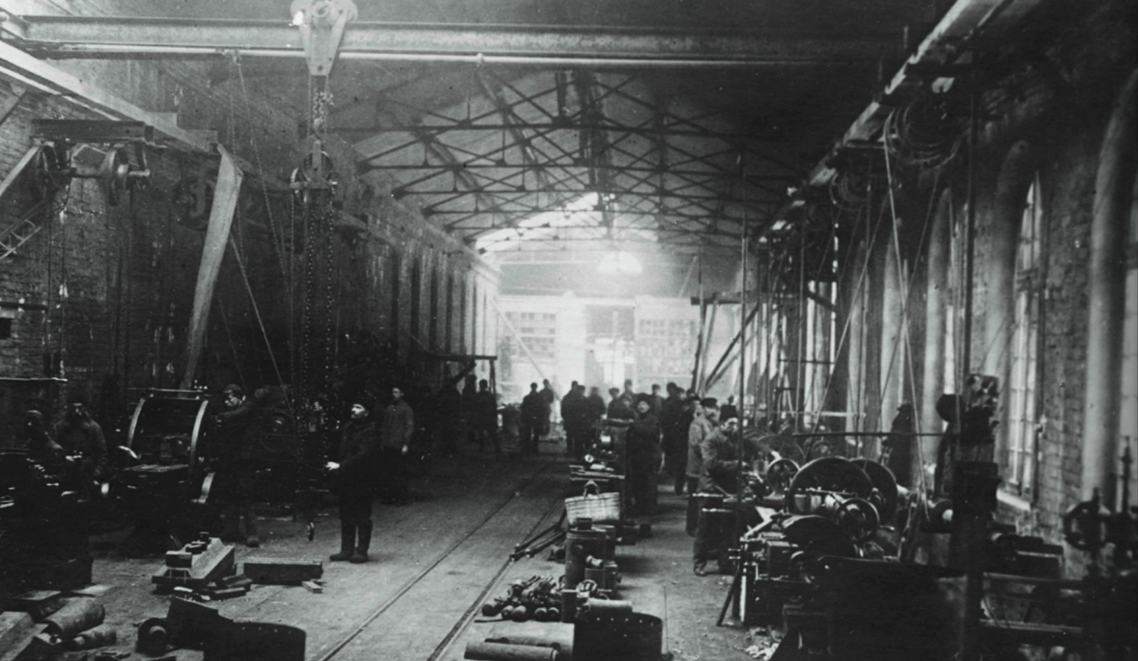
Ремонтно-механический цех. 1929 год
