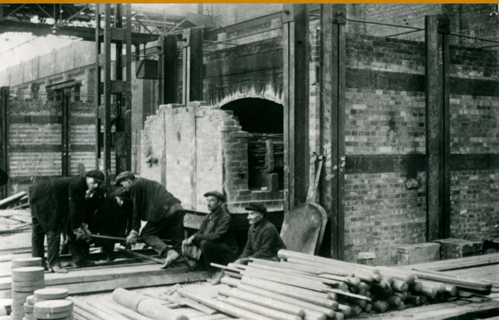
Термический цех. Отжигательные печи с выдвжным подом. 1930-е годы
